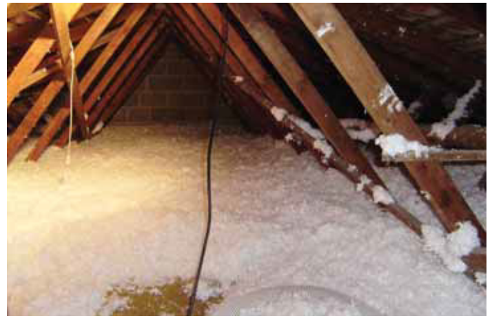
Vindisoleringsblåsning med glasfiber (NESTA SAS, Frankrike)
