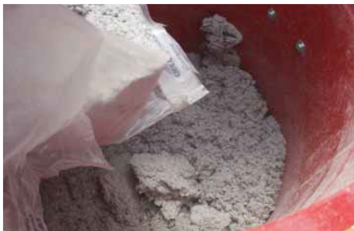
Vid installation av det hållbara isoleringsmaterialet cellulosafiber
