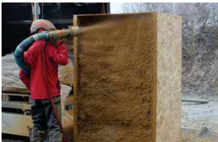
Funktionskontroll av isoleringsmaterial och blåsmaskin
