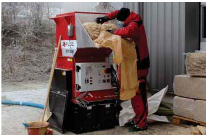
Påfyllning av maskinen med naturligt isoleringsmaterial
